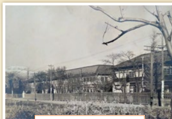
南側から見た旧校舎
